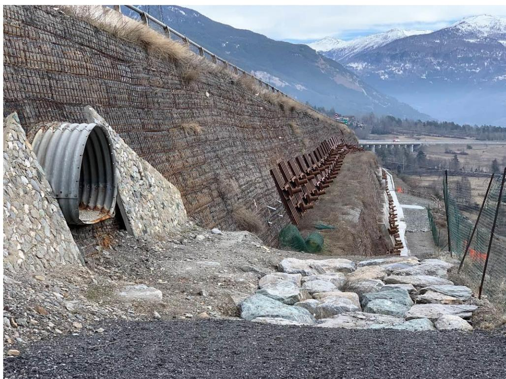
**Figura 9:** rilevato dell'autostrada A32 (discesa). Evidente la non linearità dei livelli di terra rinforzata.
