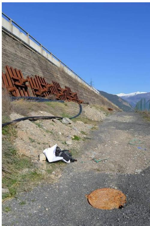
**Figura 7:** vista da strada di servizio dell'autostrada A32, che mette in evidenza una porzione dell'area d'intervento ove verranno installati ulteriori tiranti.
