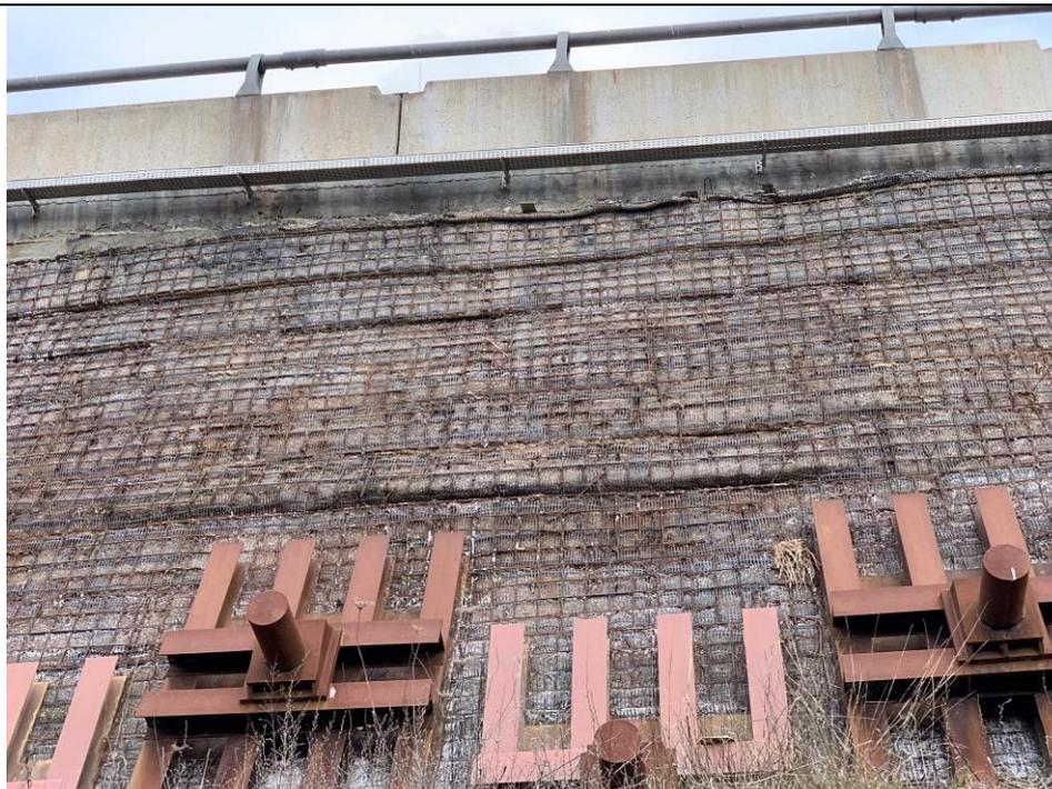
**Figura 10:** deformazione del rilevato in terra rinforzata con compenetrazioni e spanciamenti dei casseri in rete elettrosaldata e rilasci delle geogriglie.
