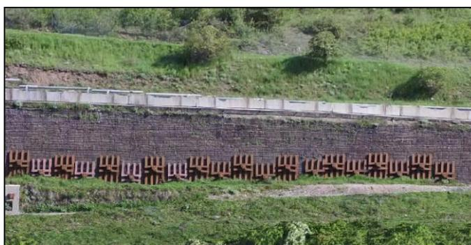
Il terzo tratto "C", di lunghezza pari a circa 80 m, è a singolo paramento e di altezza variabile tra 4,0 m e 7,7. Esso è interessato, solo per la metà più orientale, da trattamenti colonnari di micro-jet grouting armati con tubi in acciaio, per una profondità di circa 10 m dal piano viabile.
