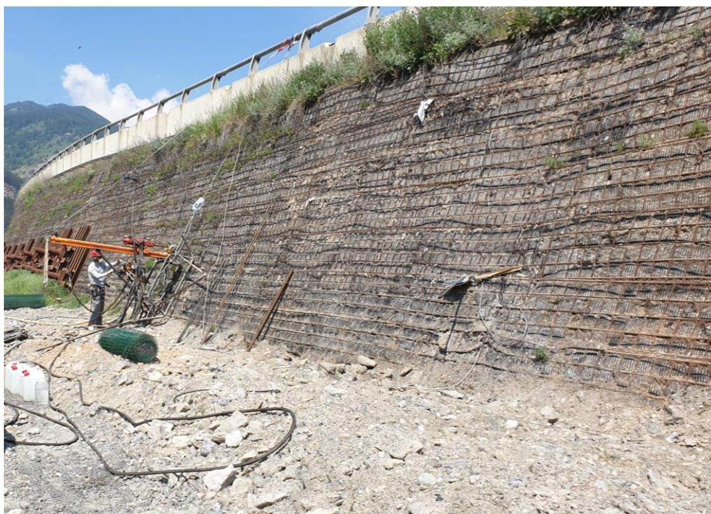
**Figura 8:** rilevato dell'autostrada A32 (discesa). Si nota l'assenza di inerbimento del paramento e il disallineamento dei livelli.
