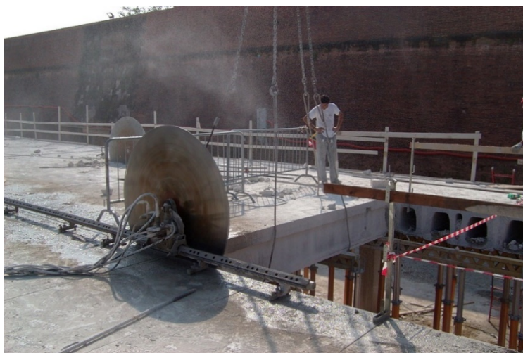
Figura 3 – Esempio taglio travi con sega circolare diamantata
