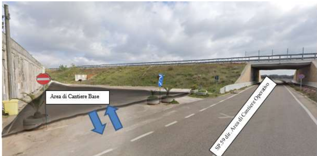
Vista dell'area di cantiere dalla SP 59
