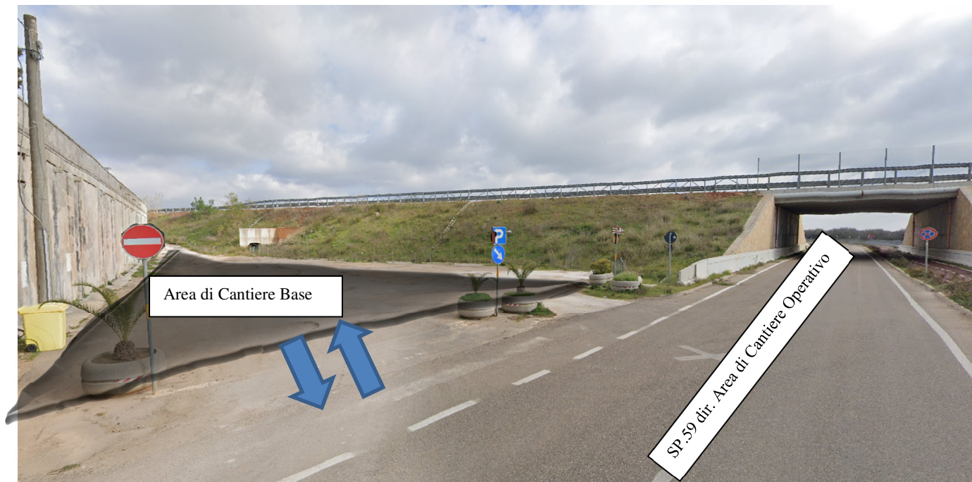
Figura 11: Vista dell'area di cantiere dalla SP 59
