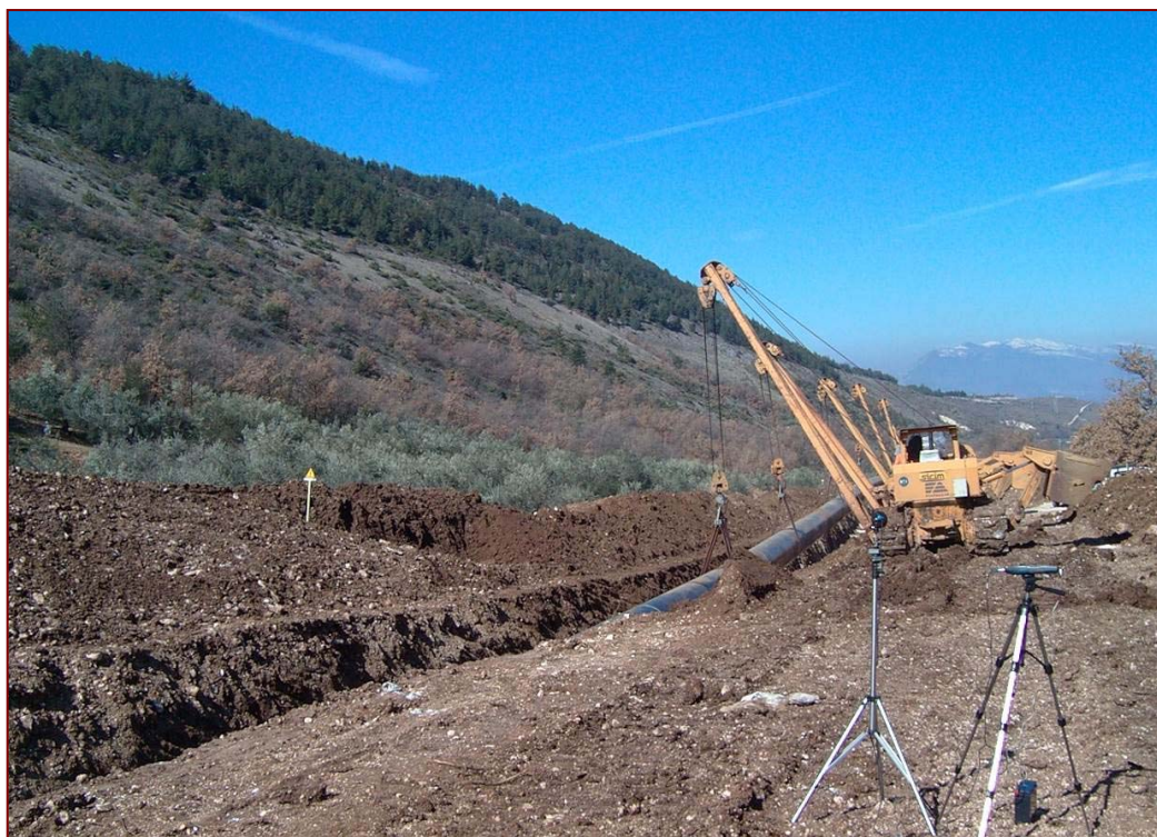
Figura 4/A – Esempio di posa di una condotta con trattori posatubi
