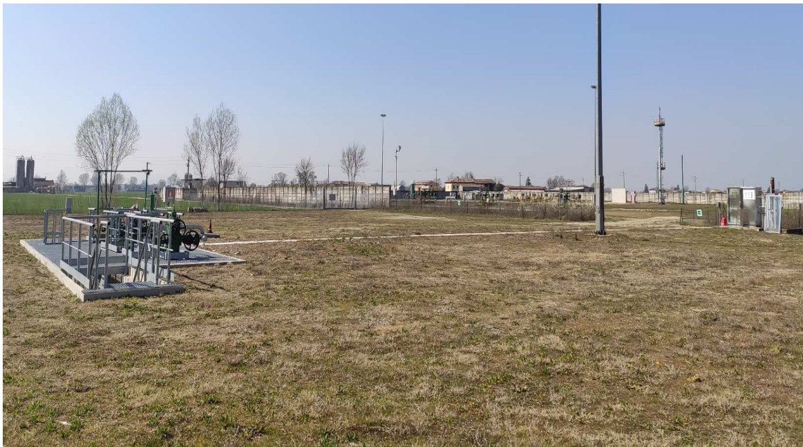
Figura 4-D - Vista esterna delle tubazioni interrato
