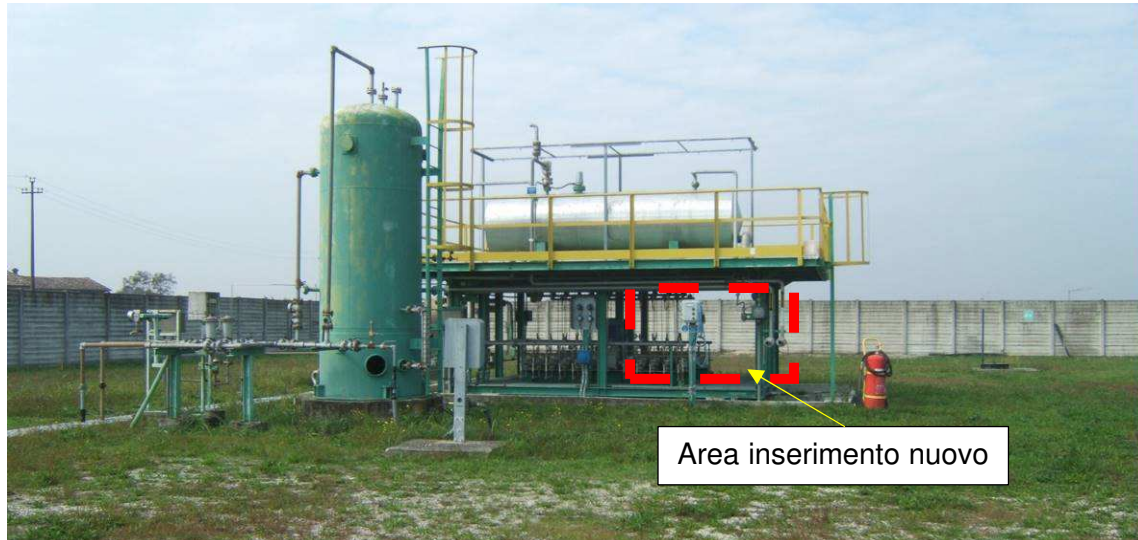
Figura 4-H - Vista Area Metanolo dove verrà installato il nuovo skid d'iniezione coperto da tettoia metallica
