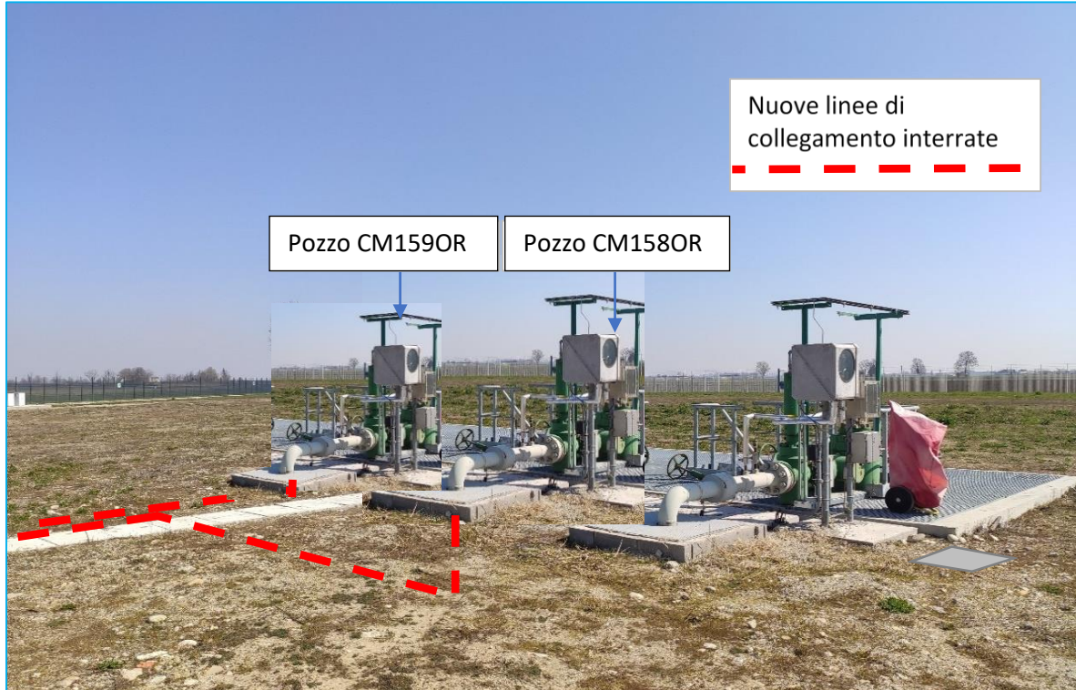
Figura 1-B - Fotoinserimento delle teste pozzo in seguito all'allaccio dei due nuovi pozzi
