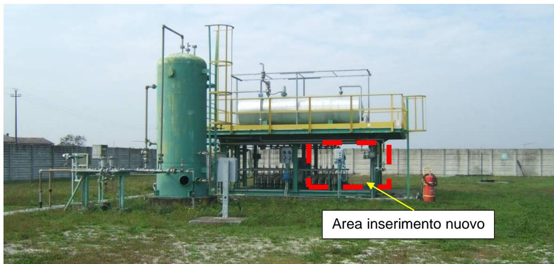
**Figura 3-H - Vista Area Metanolo dove verrà installato il nuovo skid d'iniezione coperto da tettoia metallica**
