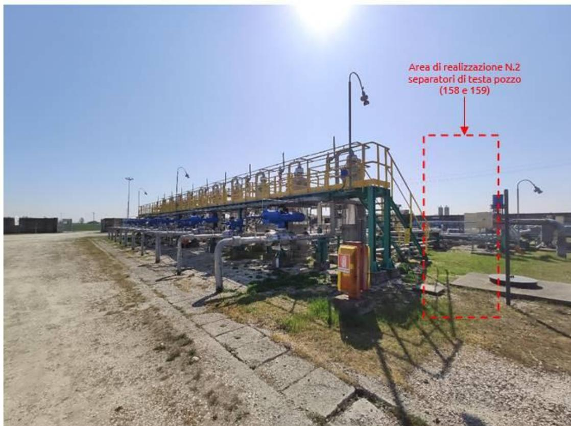
**Figura 3-F - Vista dei separatori esistenti con indicazione dell'area per i nuovi separatori**
