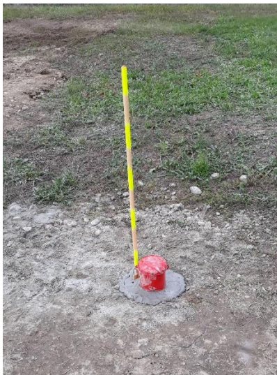
Fig. 12 – Sondaggio S1, completamento a piezometro
