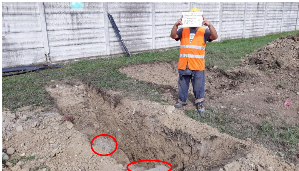
Fig. 15 – posizionamento del sondaggio AMB1 realizzato con trincea fino a 1,40m per la diffusa presenza di sottoservizi (evidenziata la sabbia che indica la presenza di condotte)
