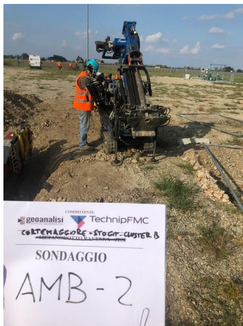
Fig. 19 – piazzamento sonda per esecuzione sondaggio AMB2
