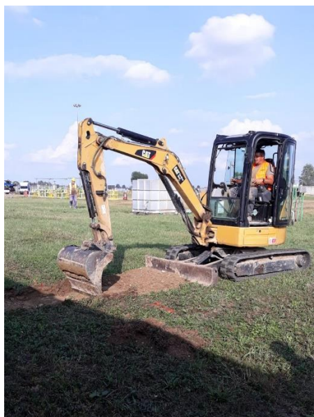
Fig. 13 – prescavo di controllo per il sondaggio AMB1
