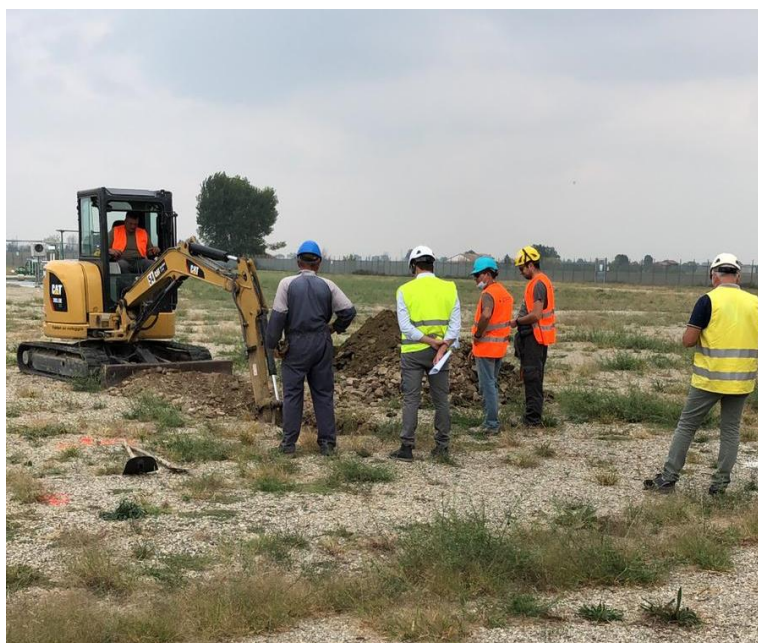
Fig. 21 – prescavo per sondaggio AMB3
