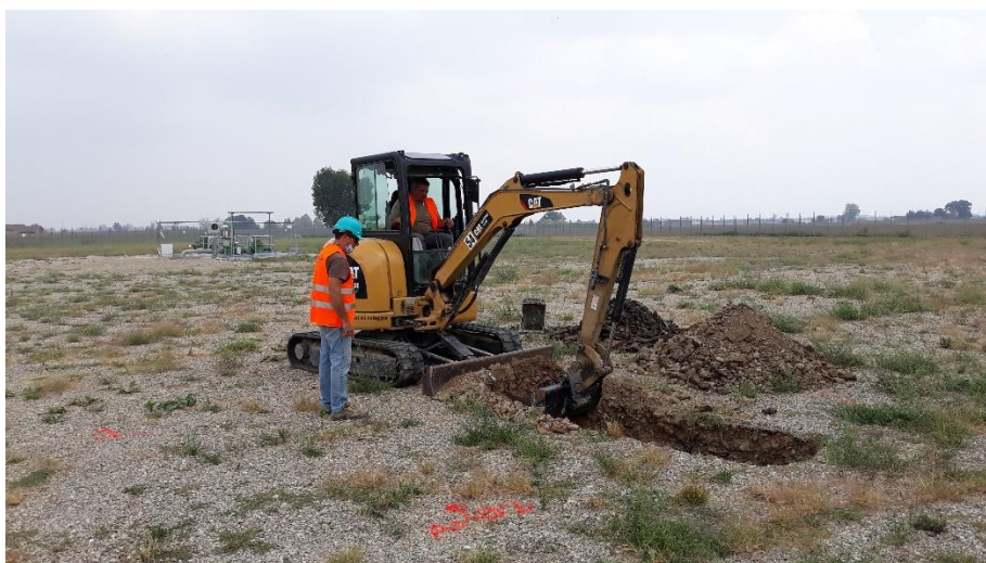
Fig. 17 – prescavo per sondaggio AMB2 / CPTU1
