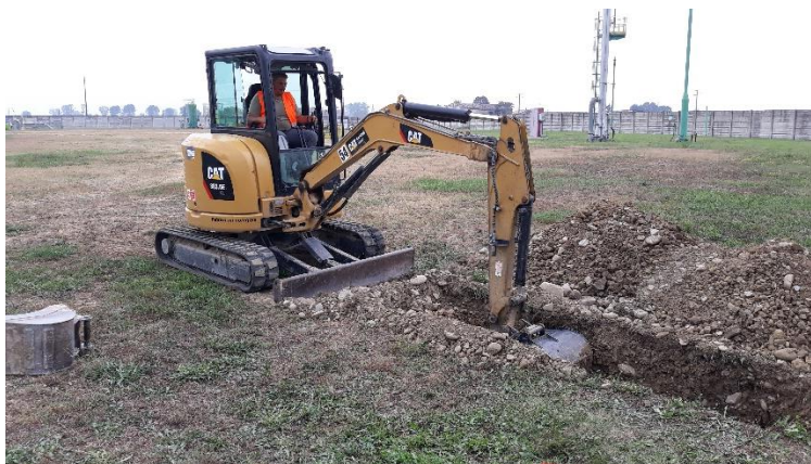
Fig. 3 – 2° tentativo di prescavo per il sondaggio S1
