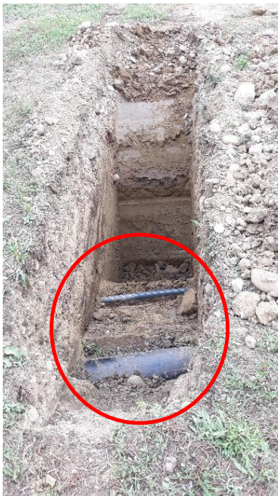
Fig. 7 – panoramica dei tubi rinvenuti durante i primi 2 tentativi di prescavo per S1 e in posizione più arretrata lo scavo definitivo
