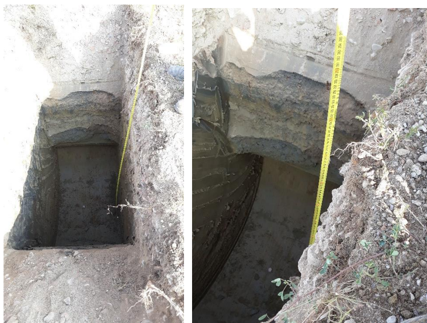
Fig. 22 – prescavo AMB3 profondità 2,50m
