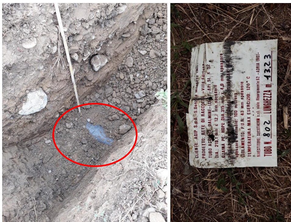
Fig. 2 – tubo rinvenuto all'interno del prescavo per S1 (prof. 1,10m) con etichetta di riconoscimento
