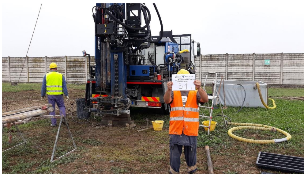
Fig. 8 – posizionamento sonda per esecuzione sondaggio S1
