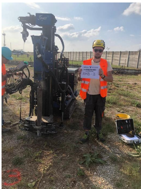
Fig. 23 – posizionamento sonda per esecuzione sondaggio AMB3
