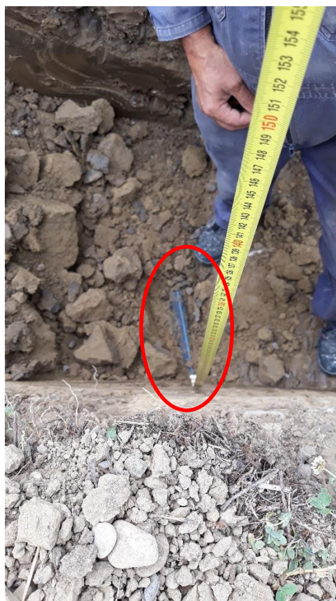
Fig. 4 – tubo rinvenuto all'interno del secondo prescavo per S1 (prof. 1,35m)
