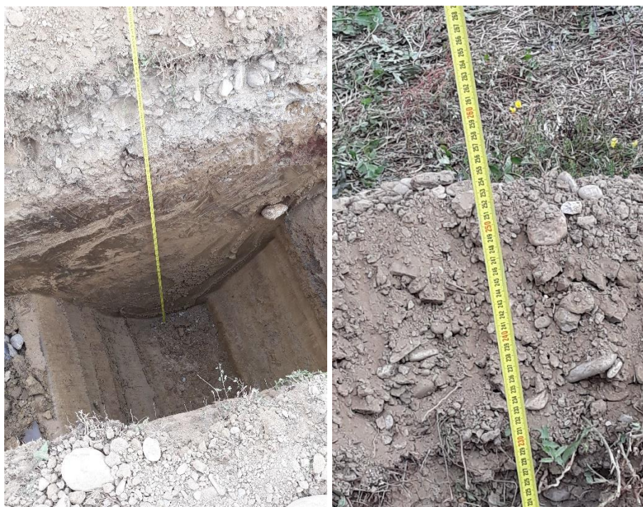
Fig. 6 – prescavo per sondaggio S1, profondità 2,50m
