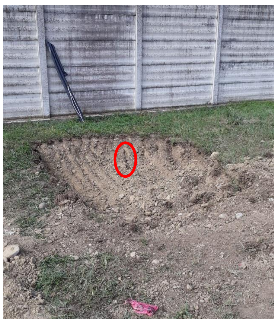
Fig. 14 – sottoservizi (linee elettriche) sconosciuti individuati durante il prescavo per AMB1
