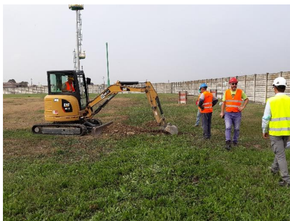
Fig. 1 – prescavo di controllo per il sondaggio S1
