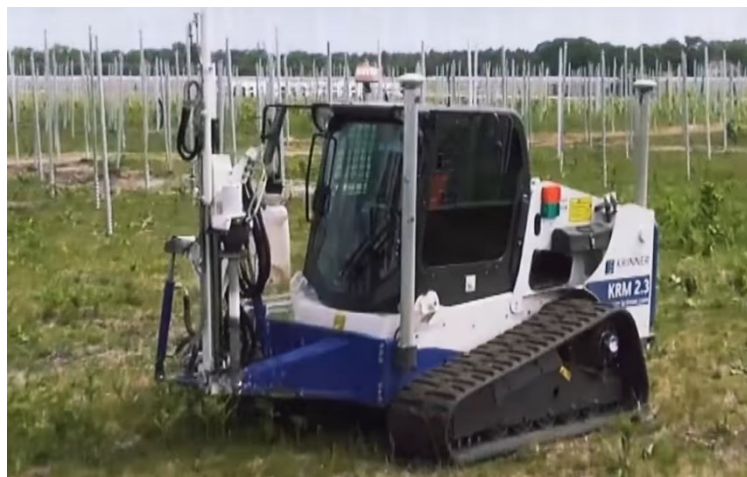
Figura 19. Esempio di fissaggio delle strutture di supporto
