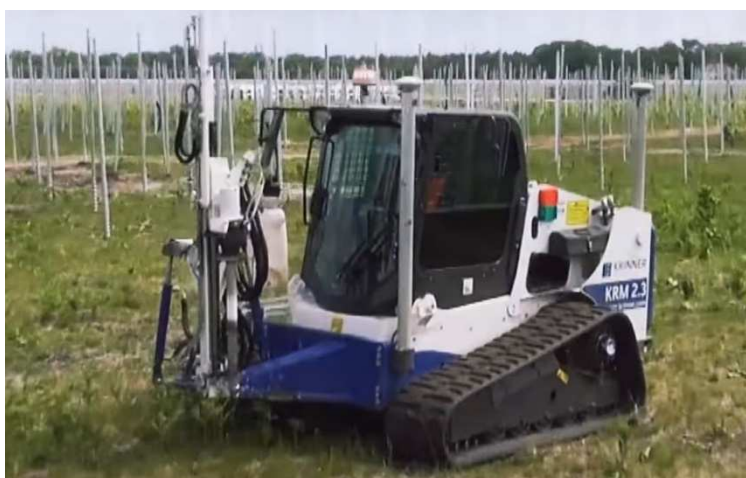
Fig.6. Esempio di fissaggio delle strutture di supporto
