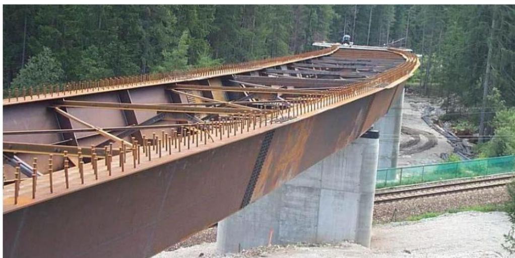
Figura 1.10 – Esempio di impalcato a cassone chiuso in costruzione
