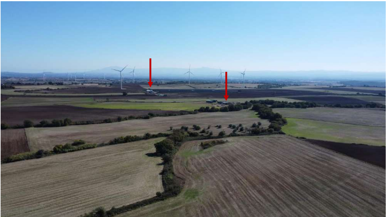
Figura 25. Elementi di degrado nei pressi dell'area d'intervento (esempio).
