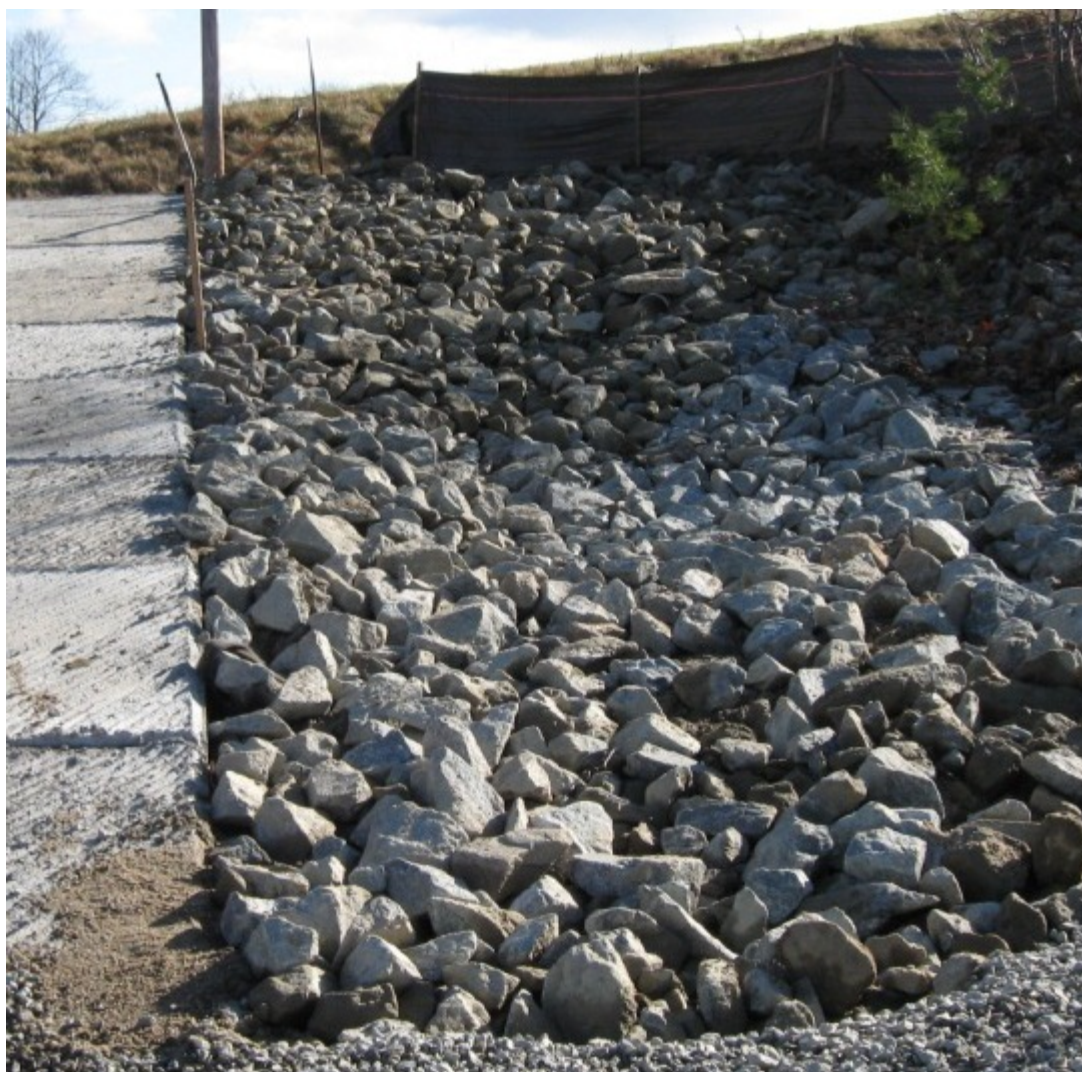
Figura 6.2 tipologia di riempimento e stesa di pietrame per realizzazione di vasca di accumulo
