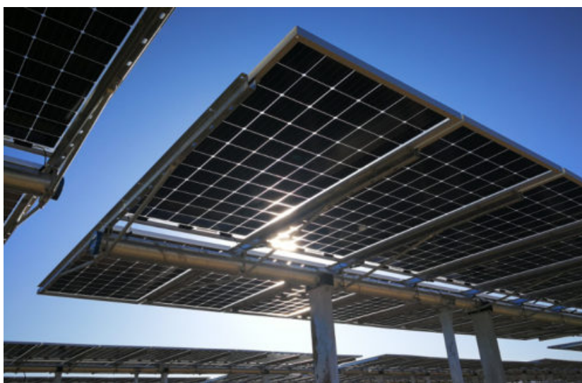
Figura 3.2: Esempio di struttura a tracker monoassiale
