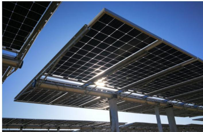
Figura 2.4: Esempio di struttura tipo tracker monoassiale
