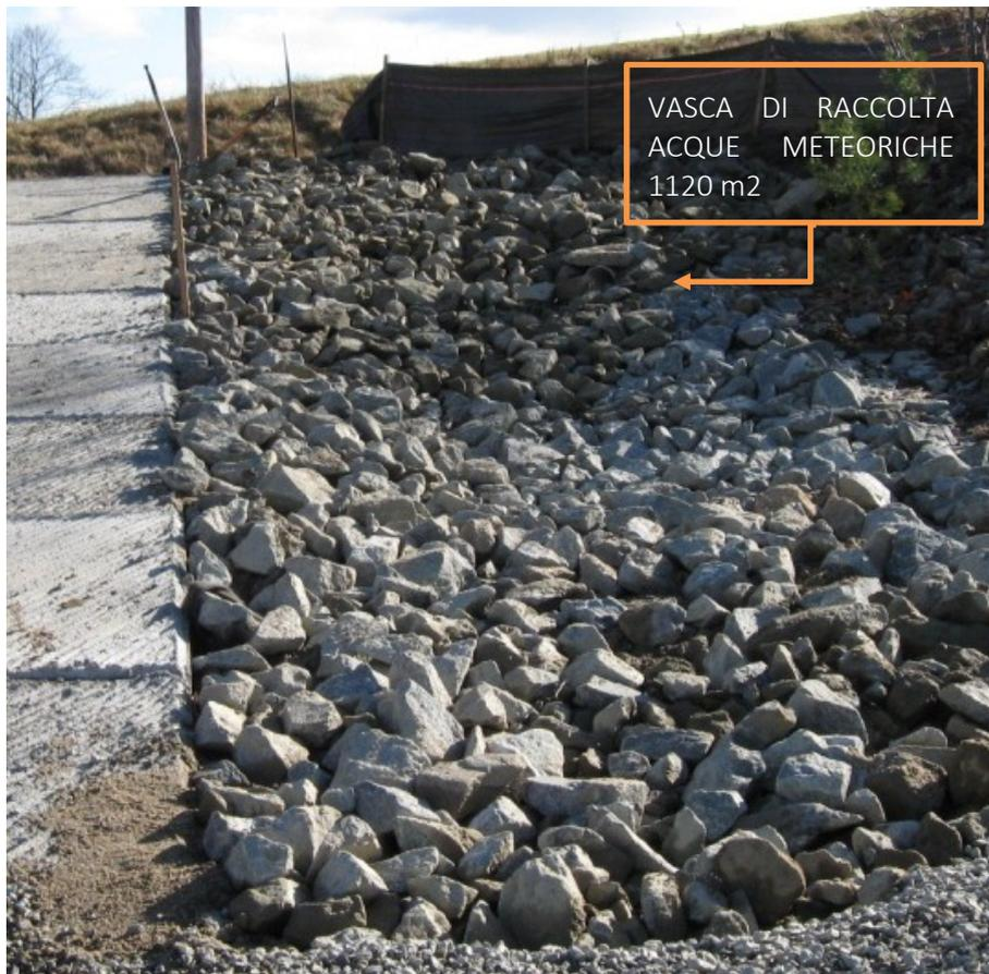
Figura 2.7: tipologia di riempimento e stesa di pietrame per realizzazione di vasca di accumulo
