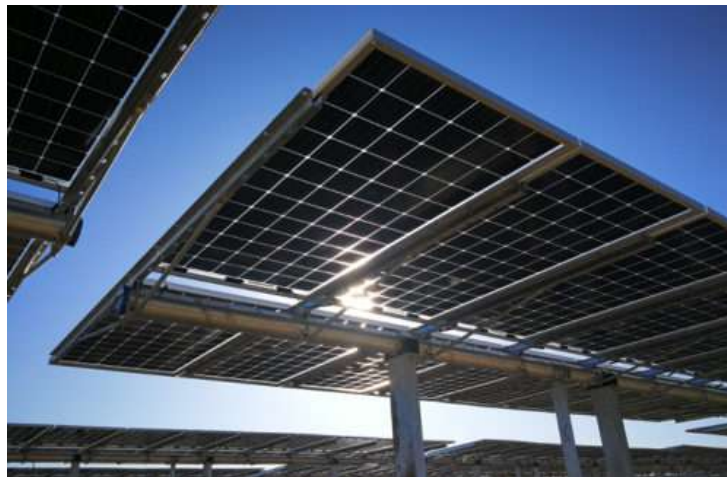
Figura 2.38: Esempio di struttura tipo tracker monoassiale
