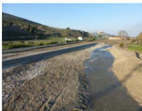
Lavori di arginatura sul T. Cervaro (CA_CE01) - 28 marzo 2017
