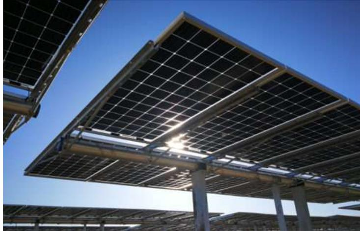
Figura 4.4: Esempio di struttura tipo tracker monoassiale
