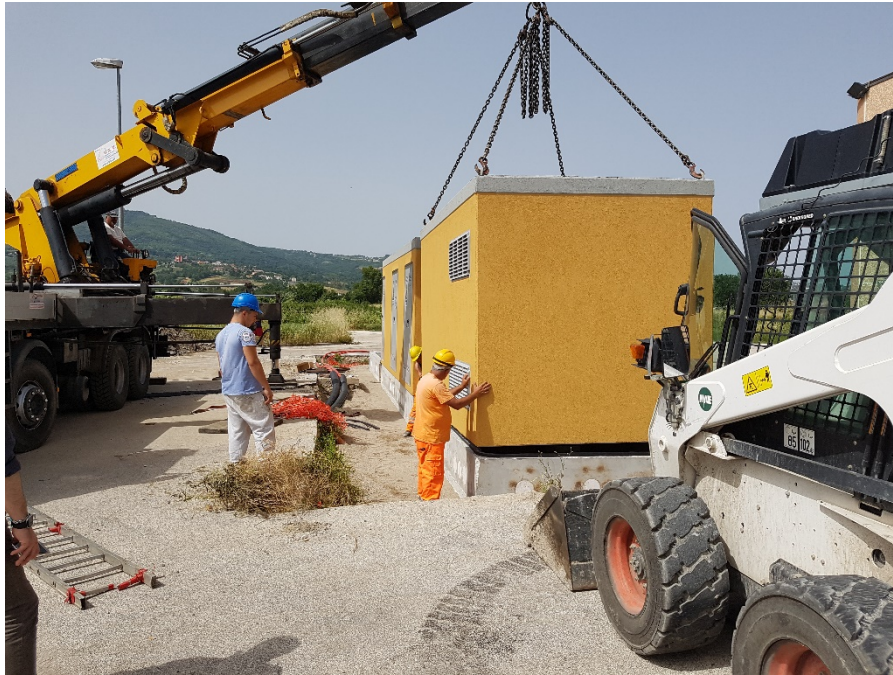
Figura 84 Esempio di posizionamento delle cabine
