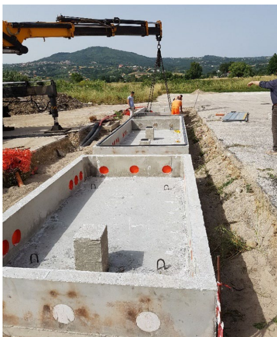
Figura 83 Esempio di basamento delle cabine
