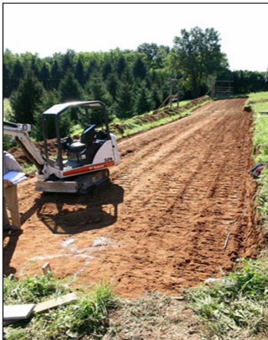
Fig. 1 Mezzi meccanici alle prese con la sistemazione del terreno
