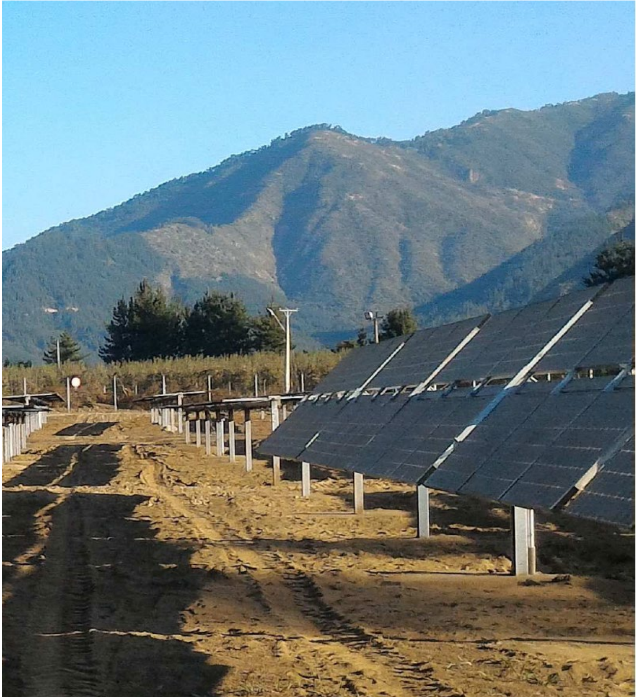
Fig. 6 Disposizione dei moduli fotovoltaici sui tracker
