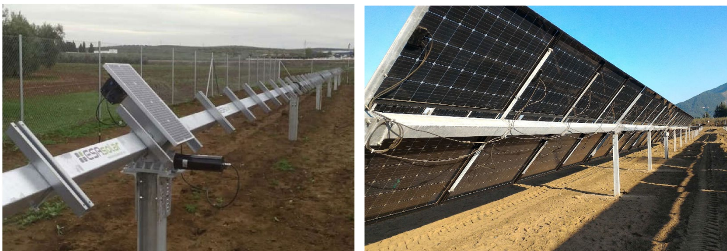
Fig.3 Predisposizione dei pali e ancoraggio delle strutture in acciaio di sostegno ai moduli fotovoltaici
