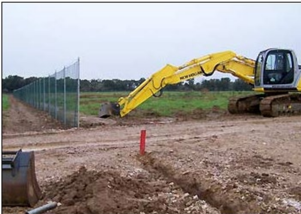
Fig. 5 Predisposizione della recinzione del parco fotovoltaico
