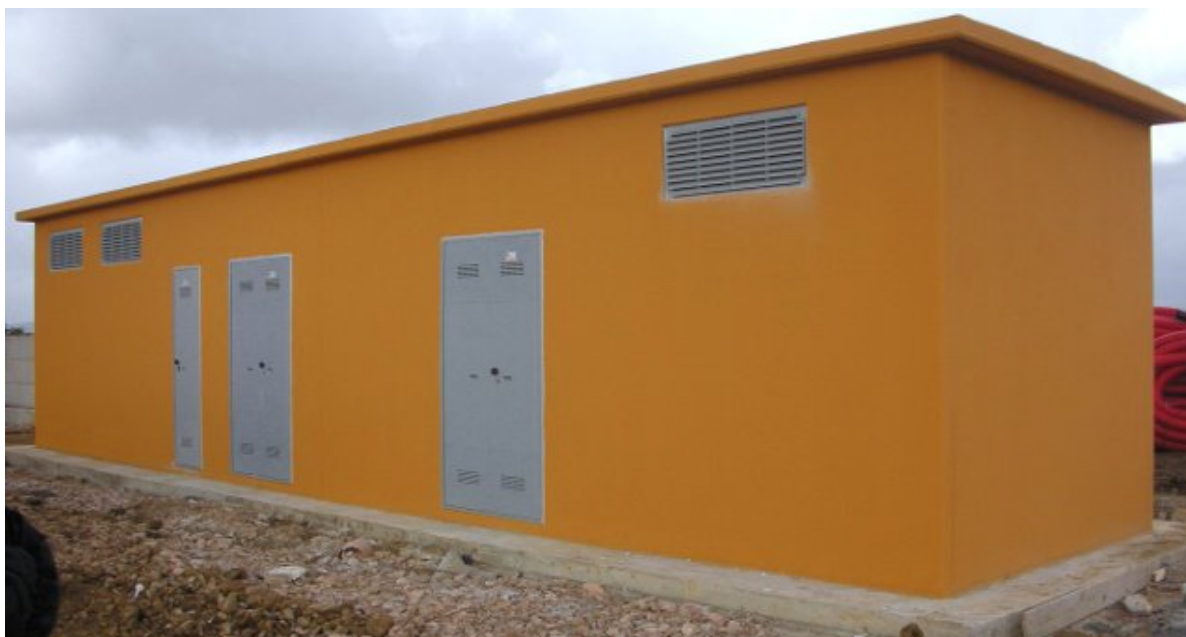
Fig.5 Posizionamento di una delle cabine elettriche
