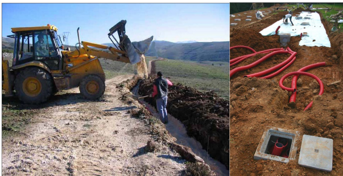
Fig. 4 Scavo e predisposizione delle tubature che ospiteranno i cavi elettrici
