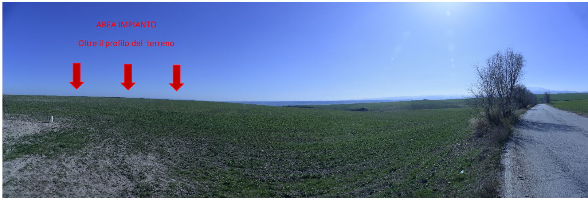
Foto 02. Distanza impianto dalla SP89 circa 1.400 metri. L'impianto non è assolutamente visibile dalla SP89
