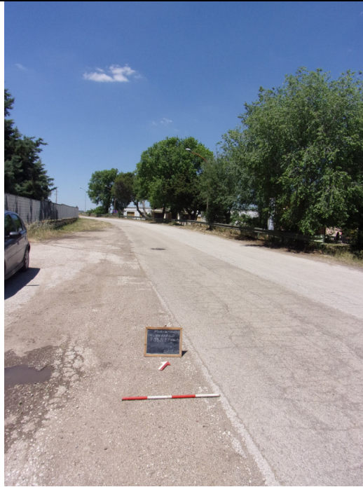
Fig. 22, percorso dell'elettrodotto su strada asfaltata SP 89, scattata da sud
