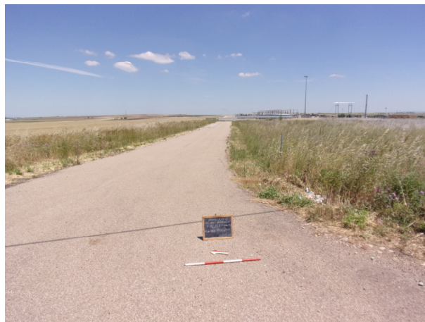
Fig. 23, percorso dell'elettrodotto che termina alla SEE Pisciole, scattata da ovest
