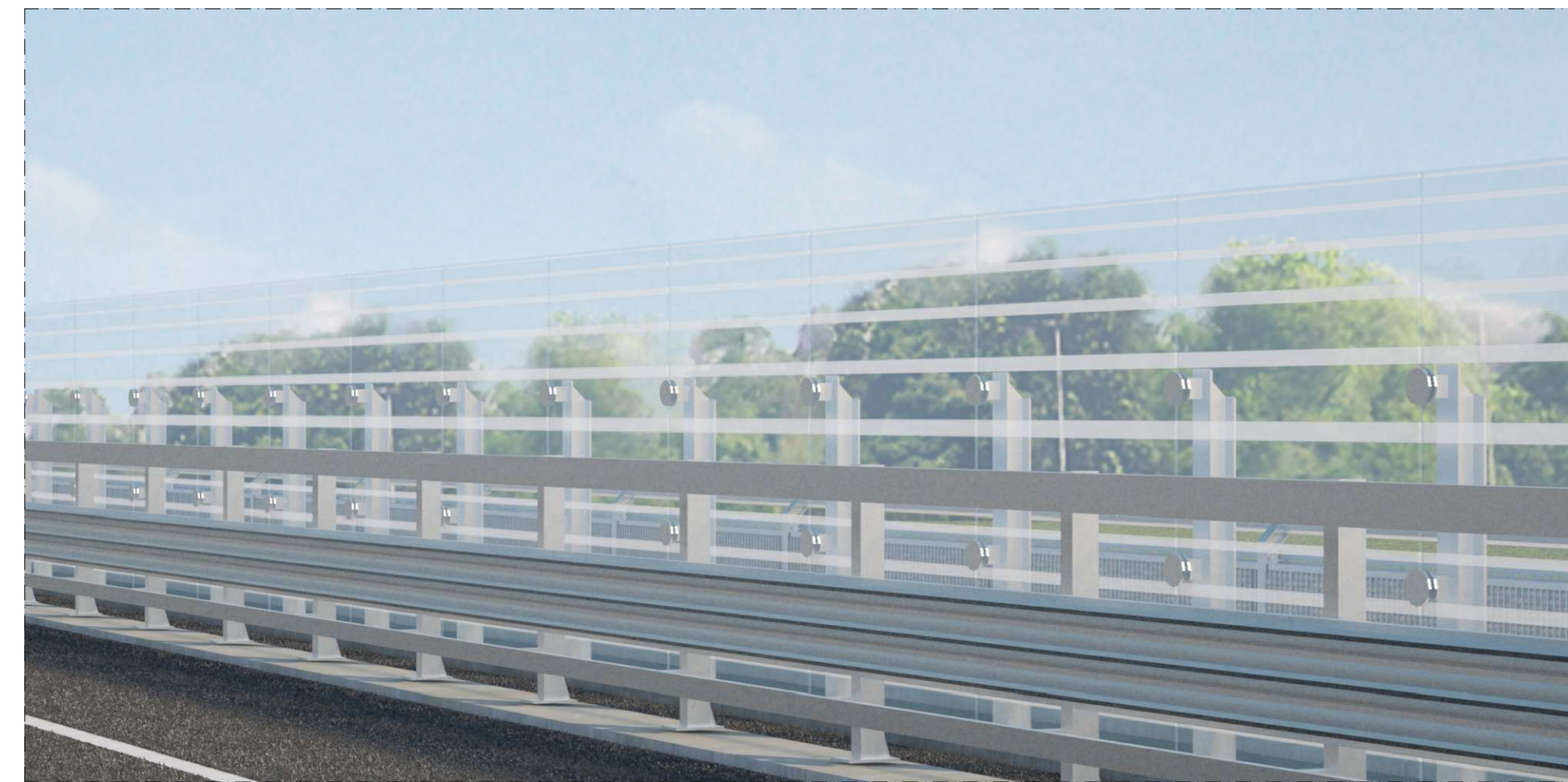
VIADOTTO AD IMPALCATO METALLICO A SEZIONE RIBASSATA: PANNELLO ACUSTICO FONOISOLANTE TRASPARENTE TIPO 1 SIMULAZIONE LATO RICETTORE
