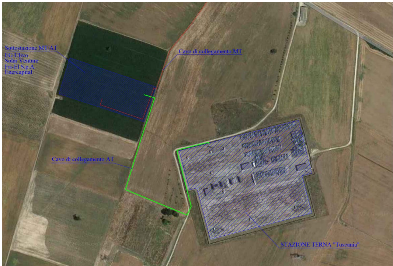
Figura 2 - Sottostazione di utenza su ortofoto
