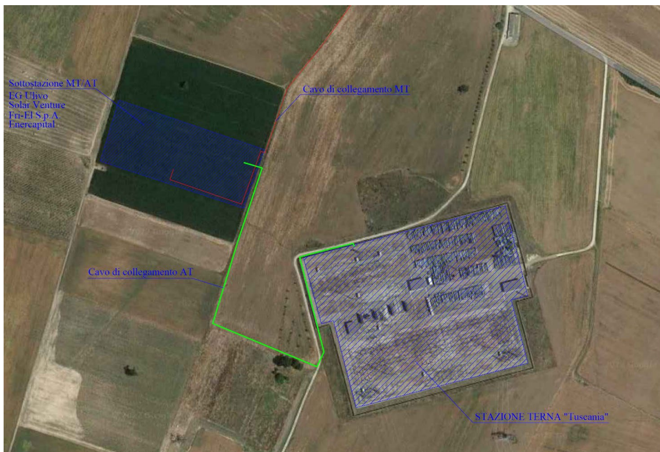
Figura 39 - Sottostazione di utenza su ortofoto
