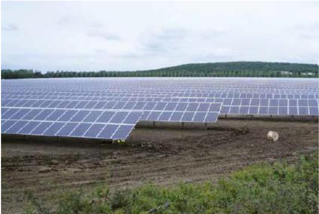
Figura 1 - immagine esemplificativa di struttura fissa in configurazione 2-P
