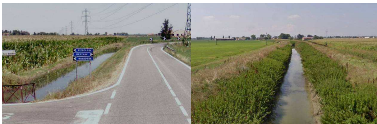
FIGURA 2-11 - VEGETAZIONE SPONTANEA IN CORRISPONDENZA DEL CAVO BURLA E CAVO TERRIERI
