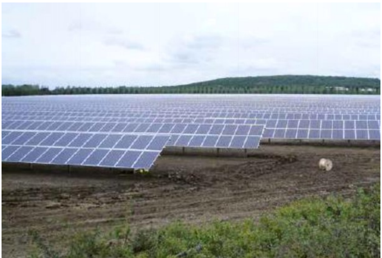
Fig. 8.2.1 – Esempio strutture fisse in conformazione 2P
