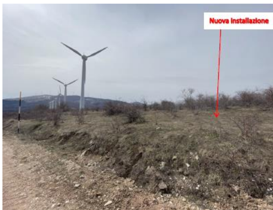
Figura 5.2: Immagini dei siti degli impianti MZ3 sopra e MZ4 sotto
