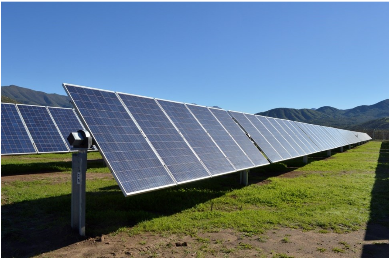
FIGURA 1 – INSTALLAZIONE SU INSEGUITORE MONO ASSIALE CON SINGOLO MODULO
