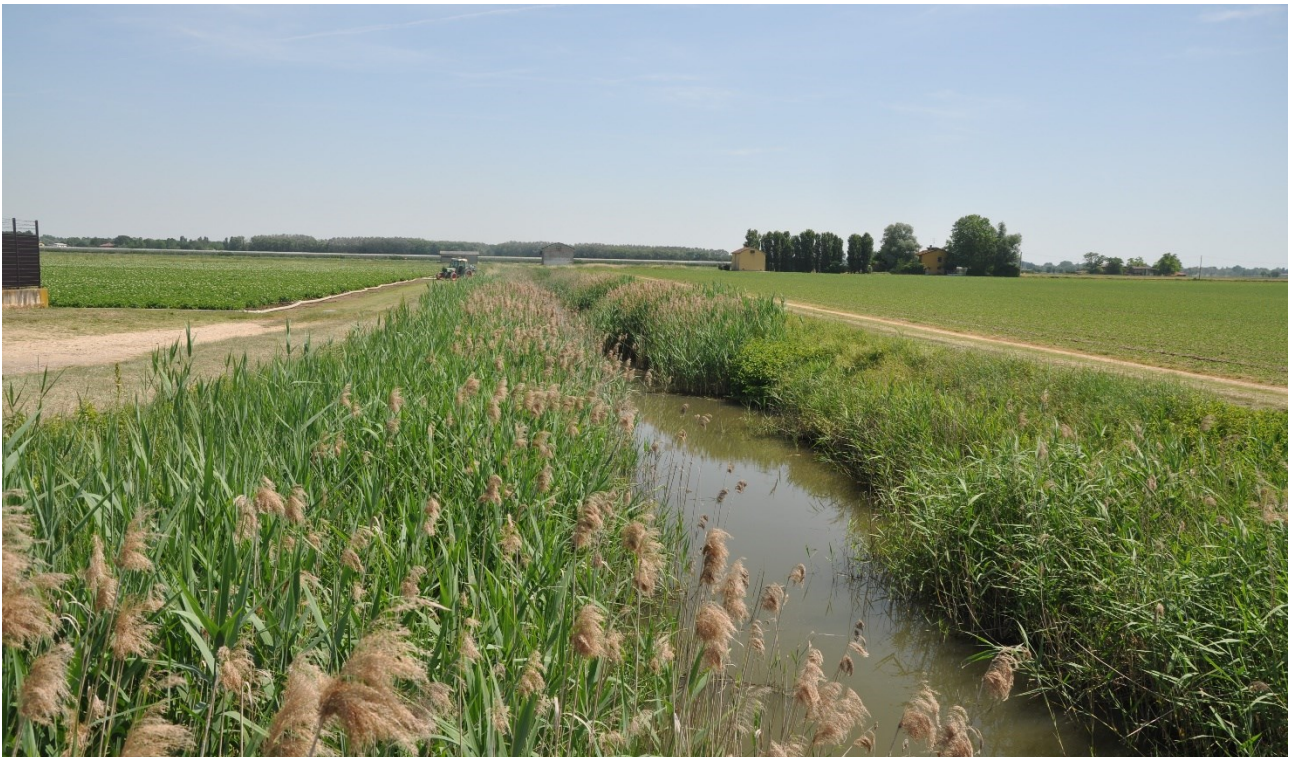
Figura 8 - Canale di raccolta delle acque
