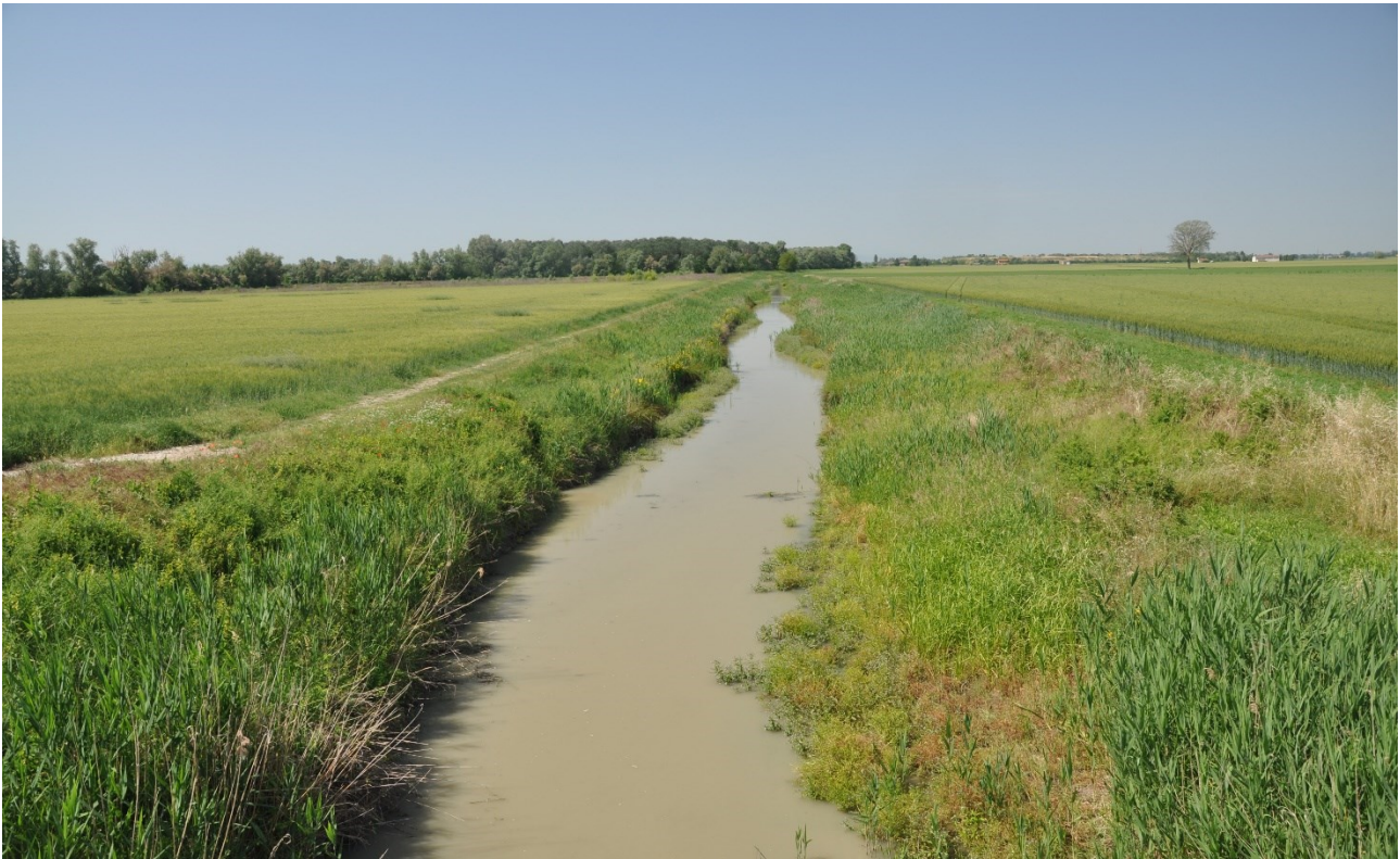
Figura 31 – Canale di raccolta gestito dal Consorzio di bonifica
