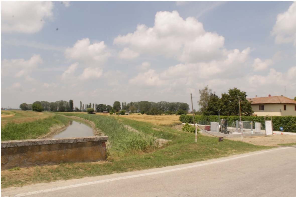
VISTA 11 – Vista dell'attraversamento n.5 Scolo Gallina Superiore
