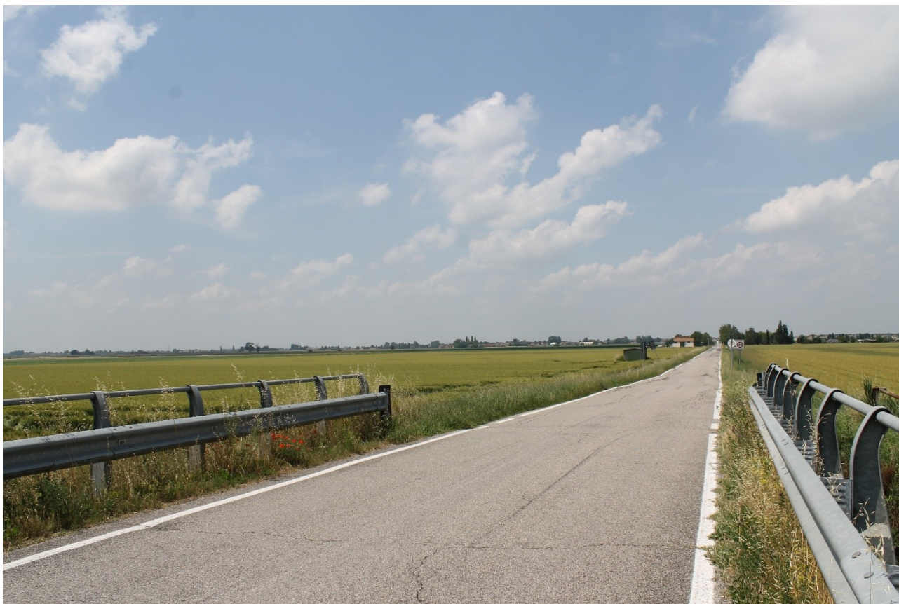
Figura 4-7: Vista della strada dal cavalcavia di Via Camerone
