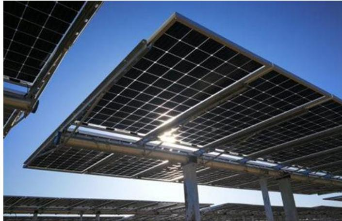
*Figura 2.3:: Particolare strutture di sostegno moduli*
