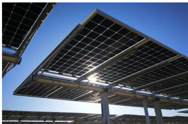
Figura 3.6: Particolare strutture di sostegno moduli
