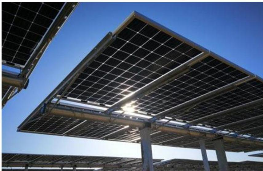
Indicativamente il portale tipico della struttura progettata è costituito da 12x2 o 24x2 moduli montati con una disposizione su due file in posizione verticale. Tale configurazione potrà variare in conseguenza della scelta del tipo di modulo fotovoltaico.
