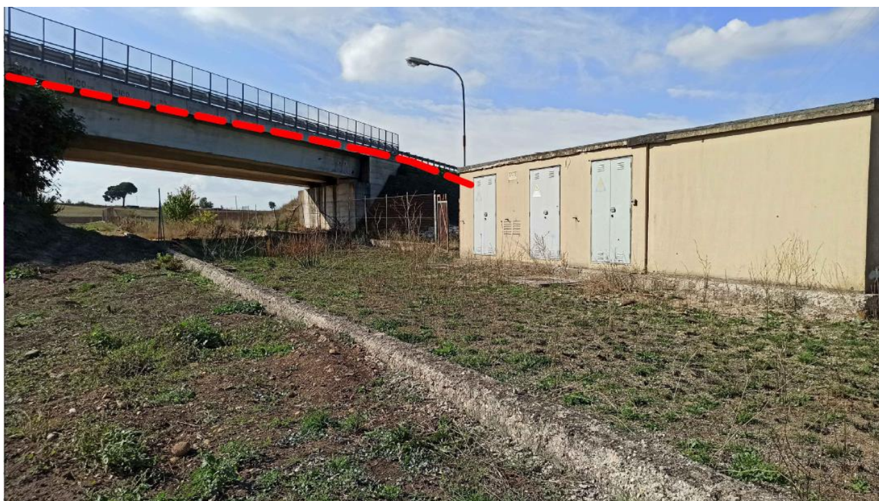
Figura 28: Parallelismo con SS n. 655 e interferenza con pozzi Consorzio di Bonifica di Basilicata
