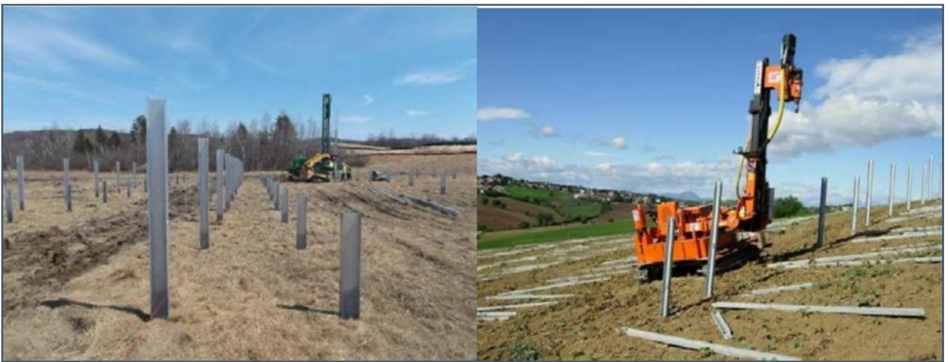
STRUTTURE DI SUPPORTO INFISSE NEL TERRENO CON MACCHINA BATTIPALI
