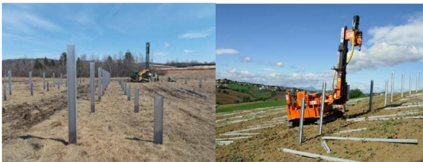
Figura 7: Infissione profili di palificazione
