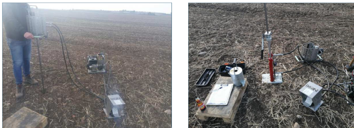
Figura 10: Prove penetrometriche eseguite
