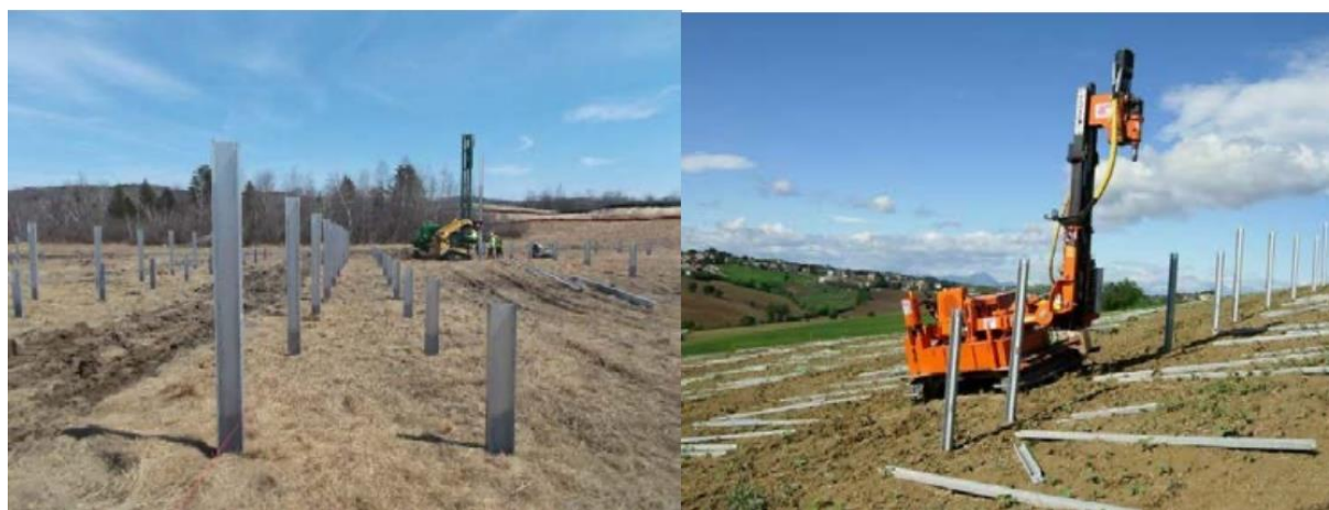
Figura 10: Infissione profili di palificazione
