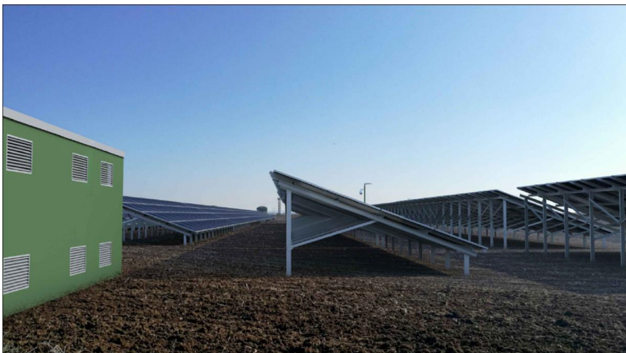
Figura 53: Fotoinserimento cabina elettrica e moduli fotovoltaici
