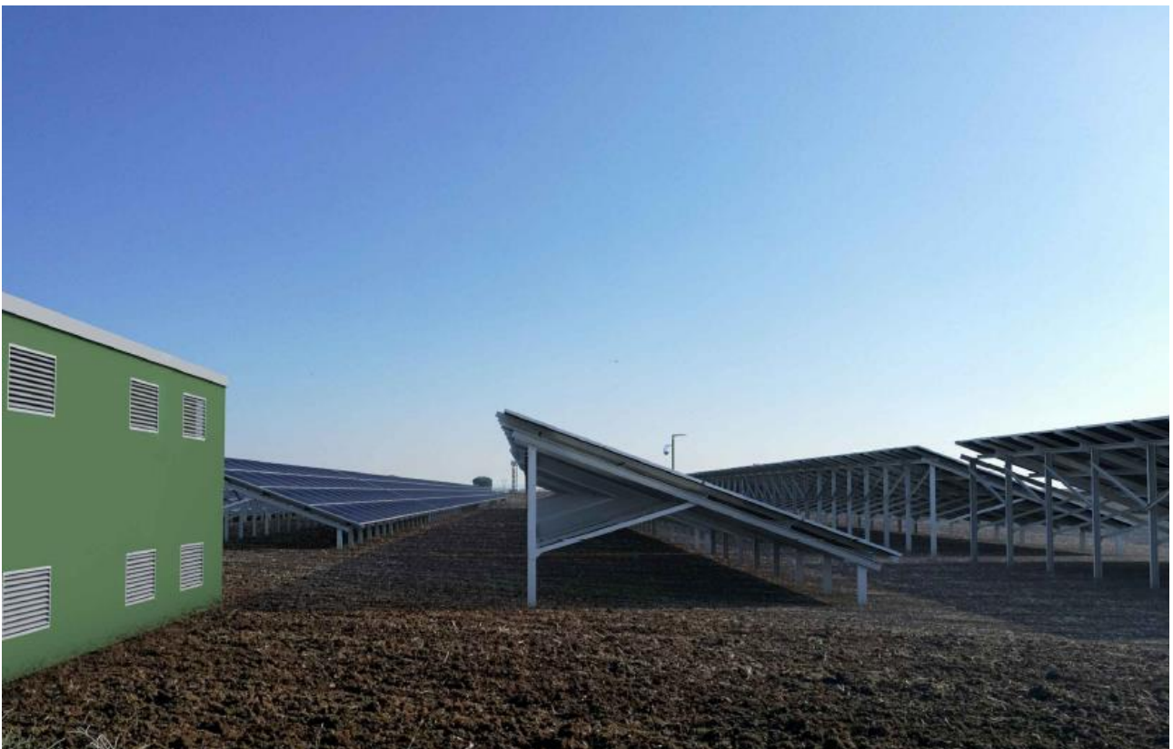
Figura 60: Vista dall'interno dell'impianto (p.to 2) - Fotoinserimento
