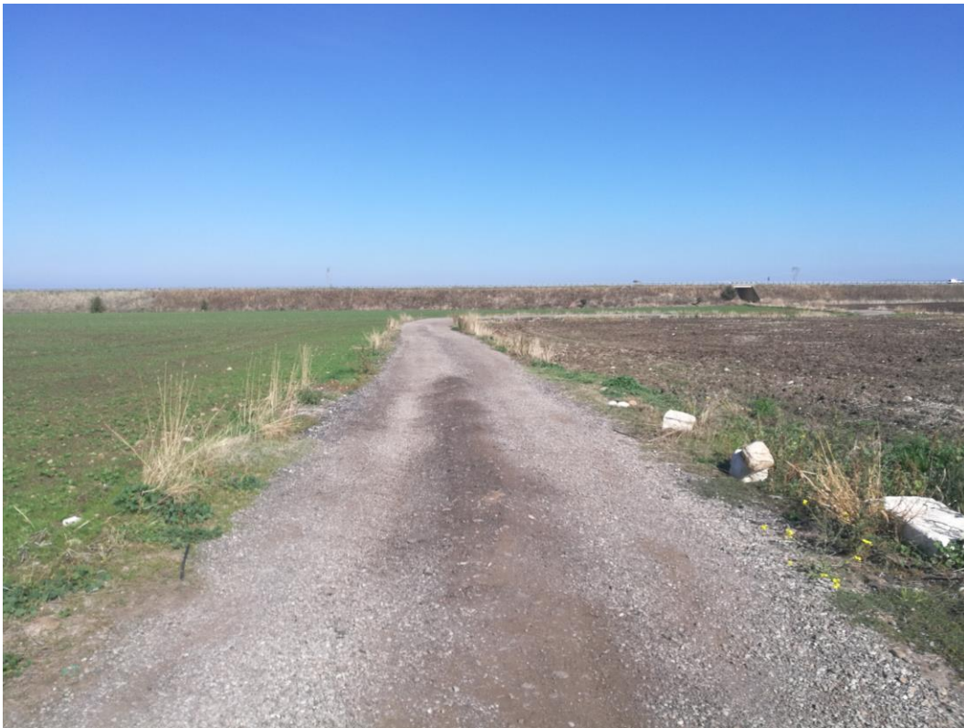
Figura 32: Percorso elettrodotto interrato MT di connessione alla rete – USCITA T.O.C.
