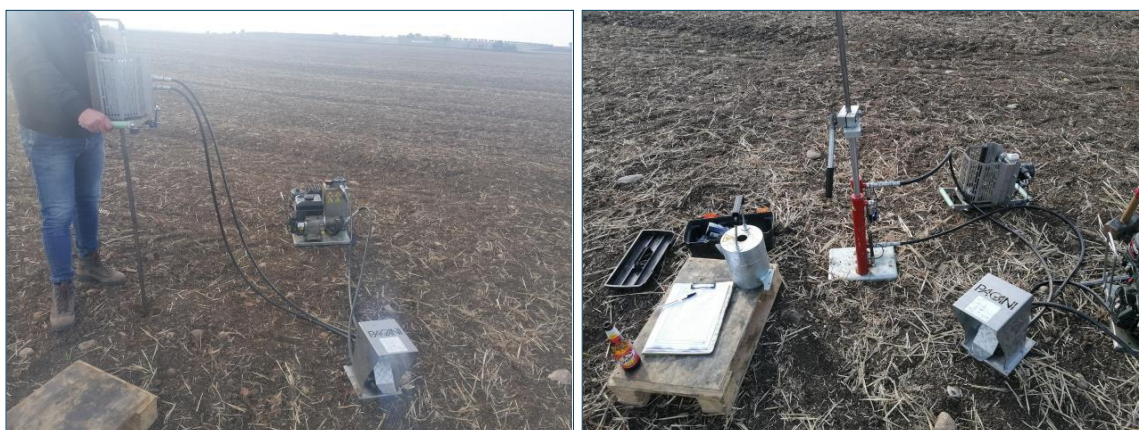
Figura 36: Prove penetrometriche eseguite
