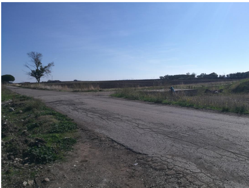
Figura 31: S.P. N. 77 – Attraversamento in T.O.C.
