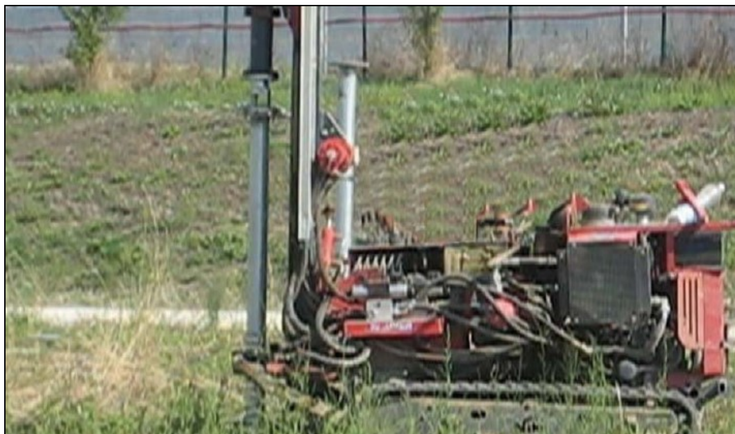
Fig. 2 inserimento pali di fondazione
