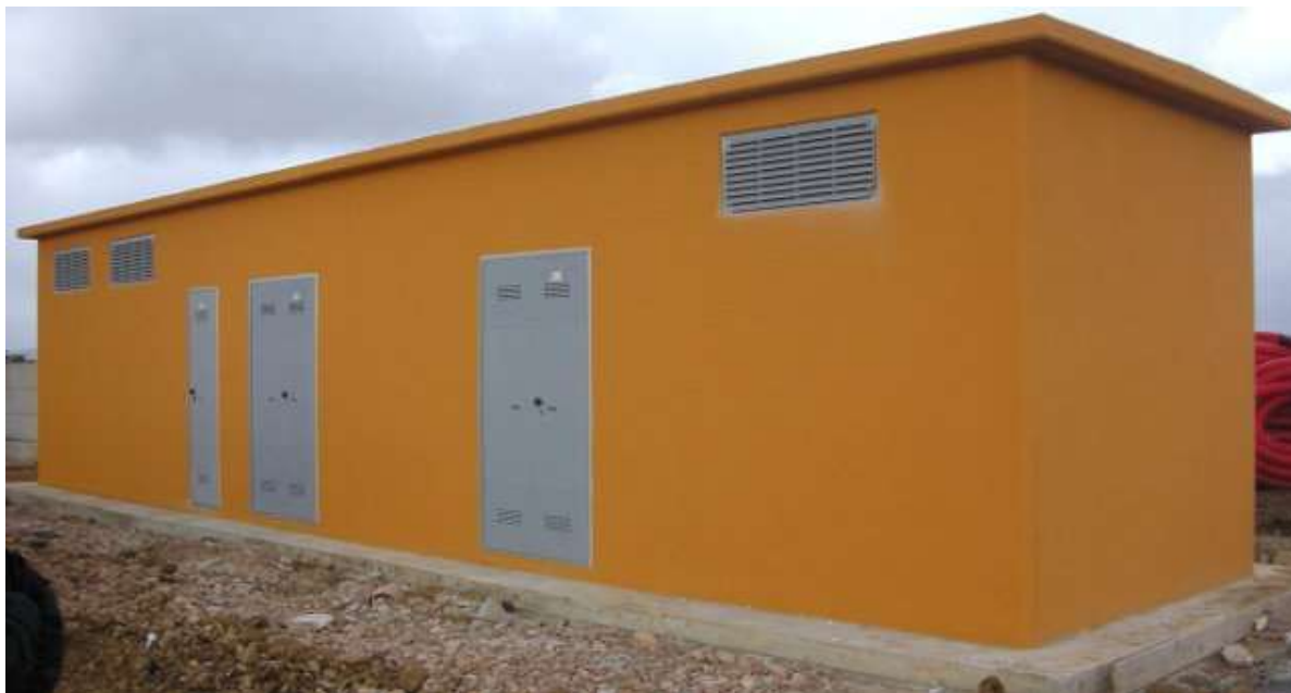
Fig.5 Posizionamento di una delle cabine elettriche
