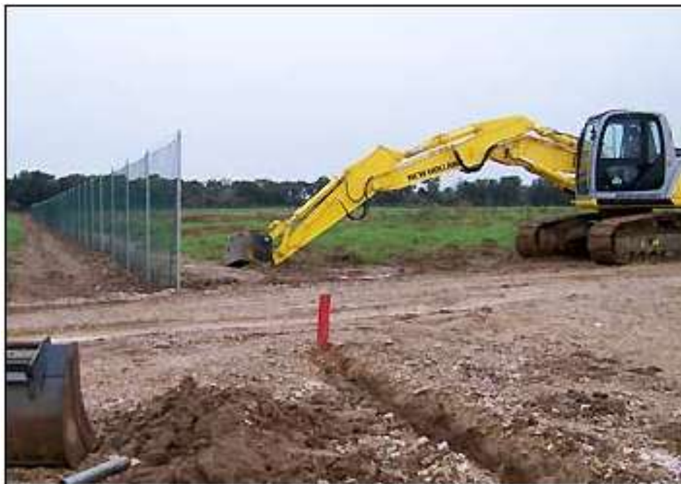
Fig. 5 Predisposizione della recinzione del parco fotovoltaico
