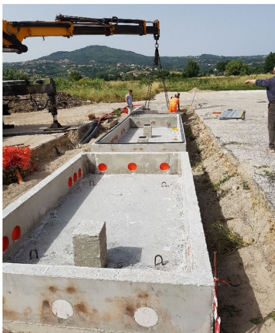
Figura 64 Esempio di basamento delle cabine
