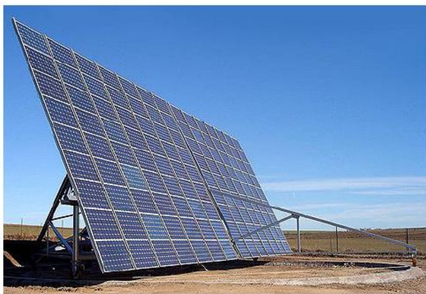
Figura 3.2-2 Inseguitori Azimut- elevazione
