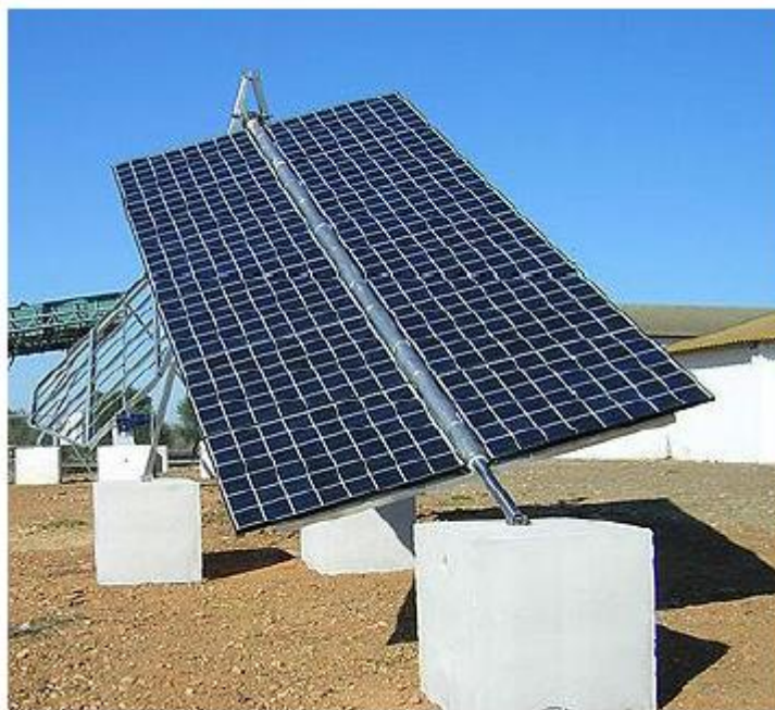
Figura 3.1-5 Inseguitori ad asse polare
