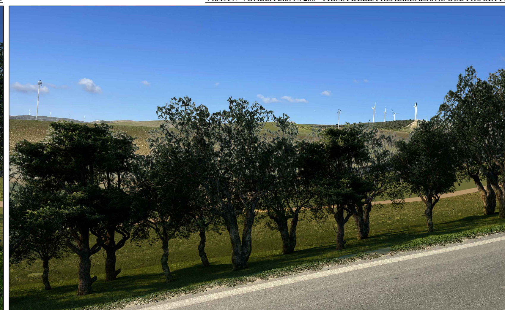
VISTA N°4 DALLA S.S. N. 288 - DOPO LA REALIZZAZIONE DEL PROGETTO
