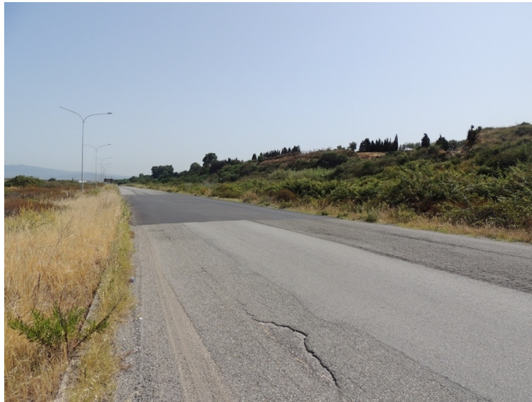
Vista del tratto della Strada Colomono all'altezza dell'imbocco galleria
