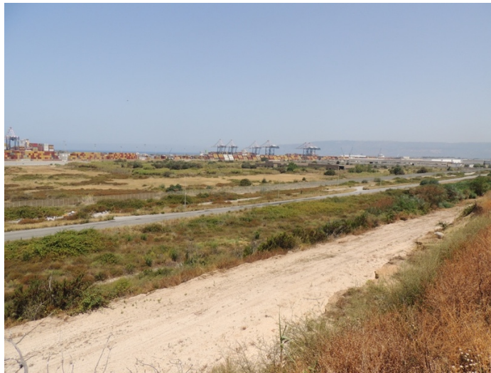
Vista della rotatoria di svincolo su via Colomono – Ante-operam
