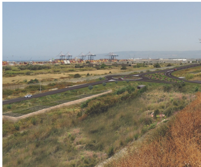
Vista della rotatoria di svincolo su via Colomono – Post-operam
