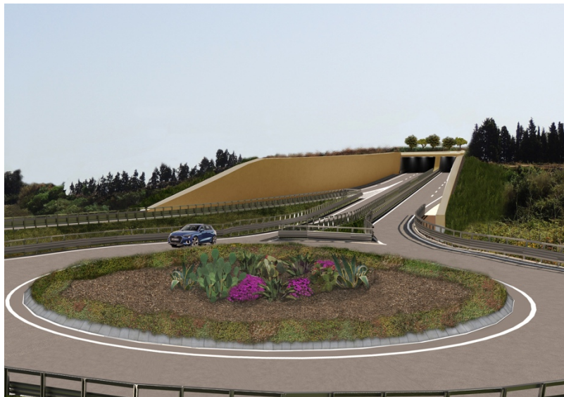
Vista della trincea di approccio alla galleria artificiale – Post-operam
