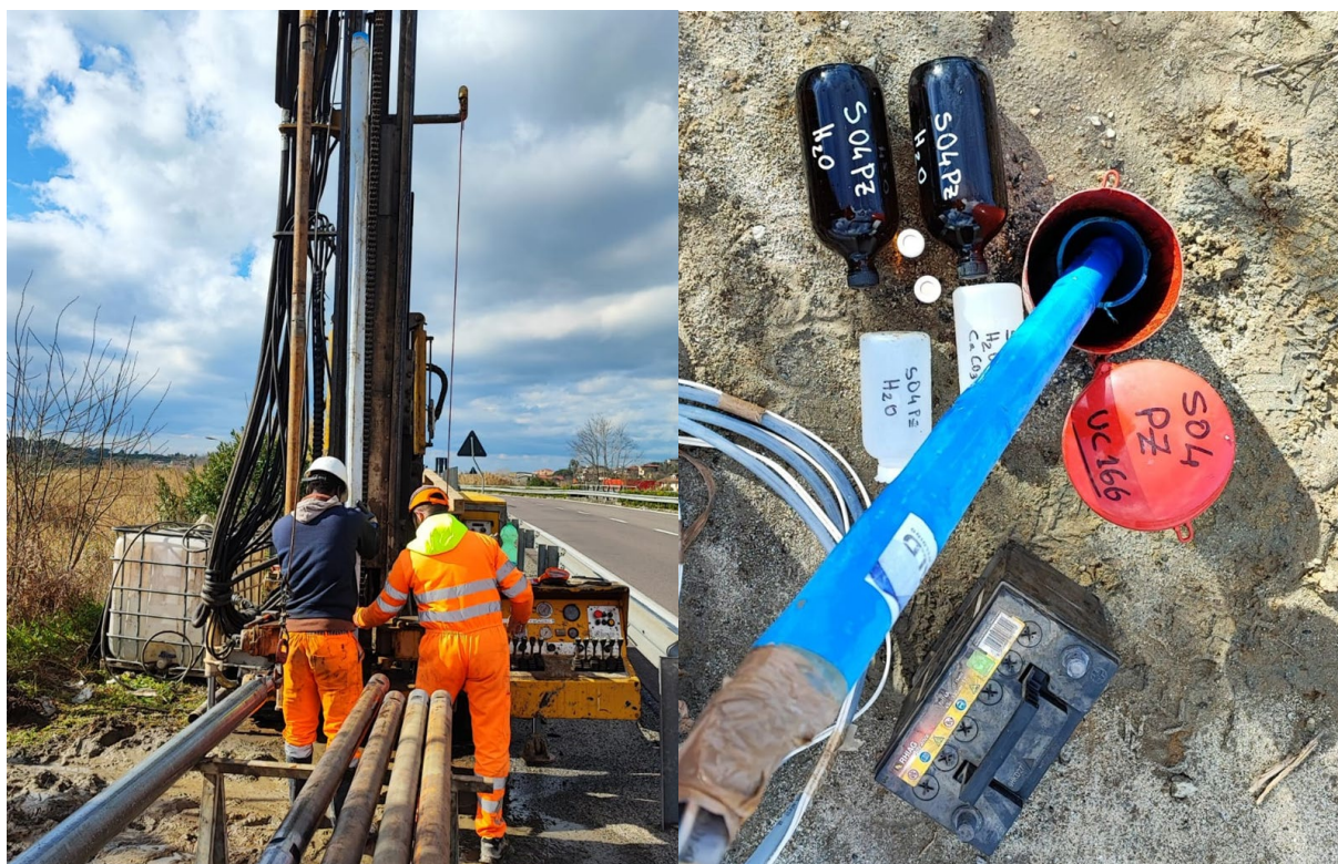
Figura 3: installazione piezometro, spurgo e prelievo campione acqua
