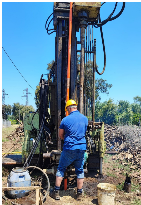
Figura 3: Installazione piezometro, spurgo e prelievo campione acqua.
