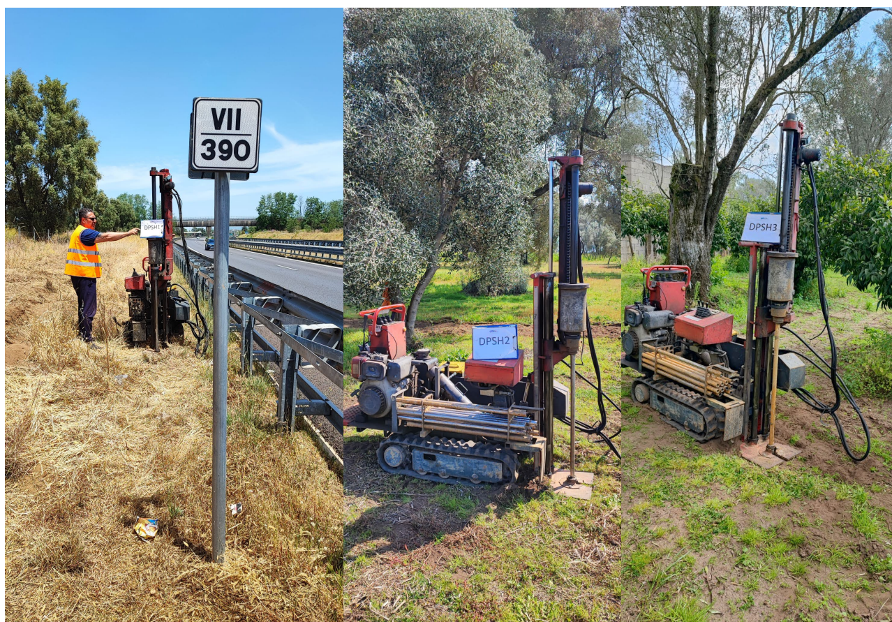
Figura 5: Penetrometro dinamico (DPSH1, DPSH2, DPSH3).
