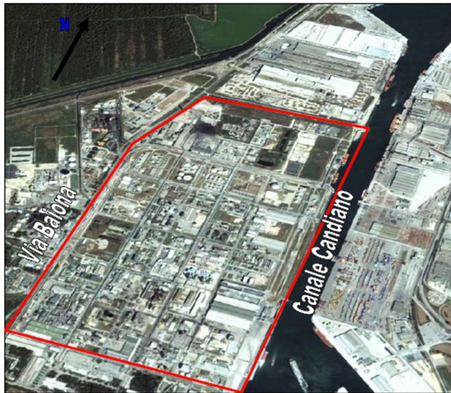
Figura 2 Foto aerea dei confini dello Stabilimento Multisocietario di Ravenna
